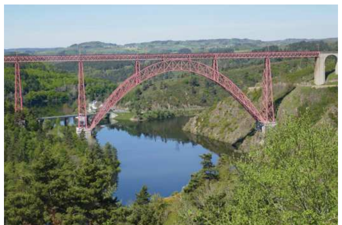
Le viaduc de Garabit
